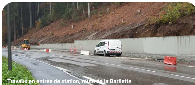
Travaux en entrée de station, route de la Barliette
